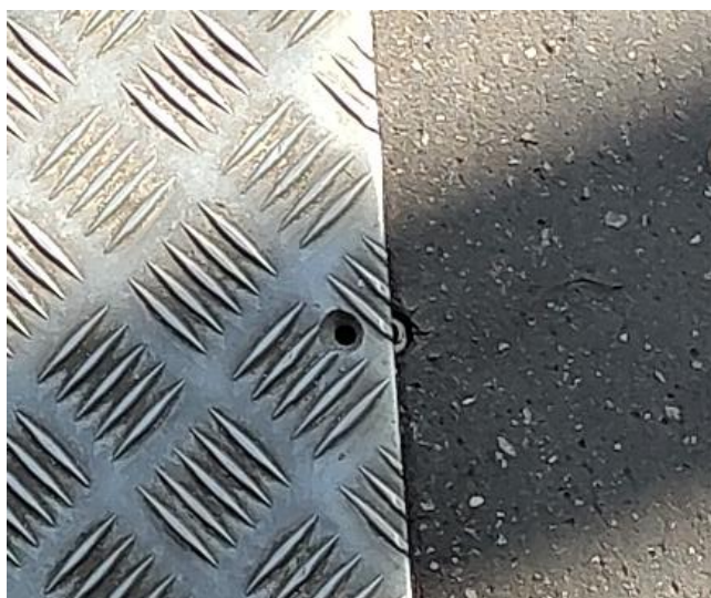
Dilatation non gérée des tabliers visible au niveau de la visserie des tôles larmées à la jonction entre la passerelle Nord et le massif maçonné.
