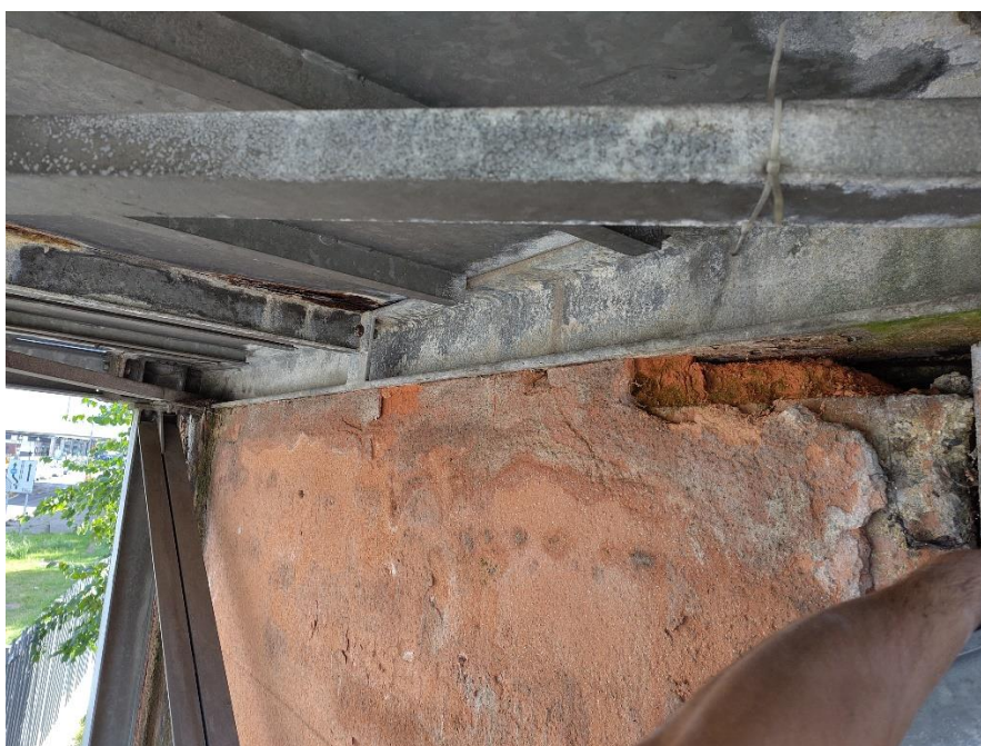
Désordres sur la culée entre l'escalier Nord et la passerelle Nord au niveau de l'appui de cette dernière Exemple de désordres au niveau d'un garde-corps maçonnés :
