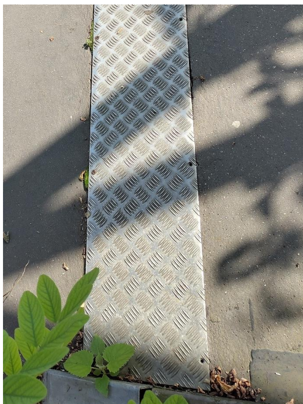
Dilatation non gérée des tabliers visible au niveau de la visserie des tôles larmées à la jonction entre la passerelle Nord et le massif maçonné.
