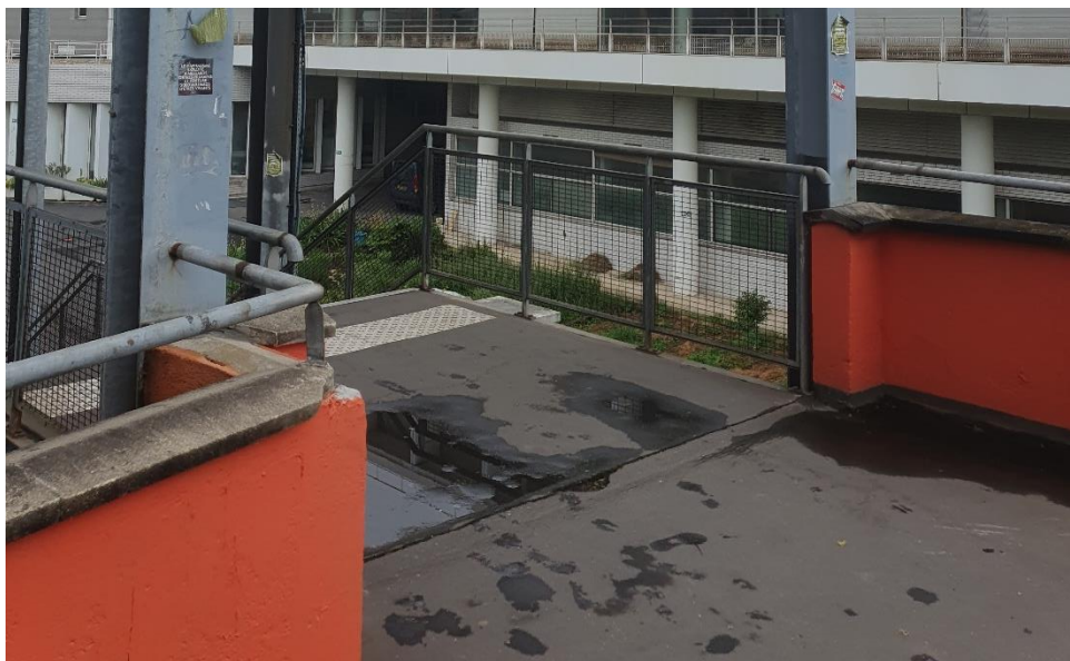
Exemple de fissuration du revêtement du tablier à la jonction entre l'escalier Nord et le massif maçonné.
