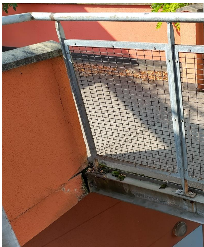
Désordres au niveau du garde-corps maçonnée sur la culée entre la passerelle Nord et l'escalier Nord Localisation : Emprise Nord- culée Nord / Emprise Sud - culée centrale.
