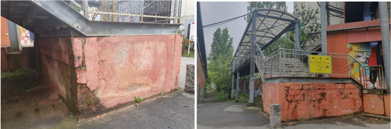
Photos massif existant : fissuration, défaut de chaînage
